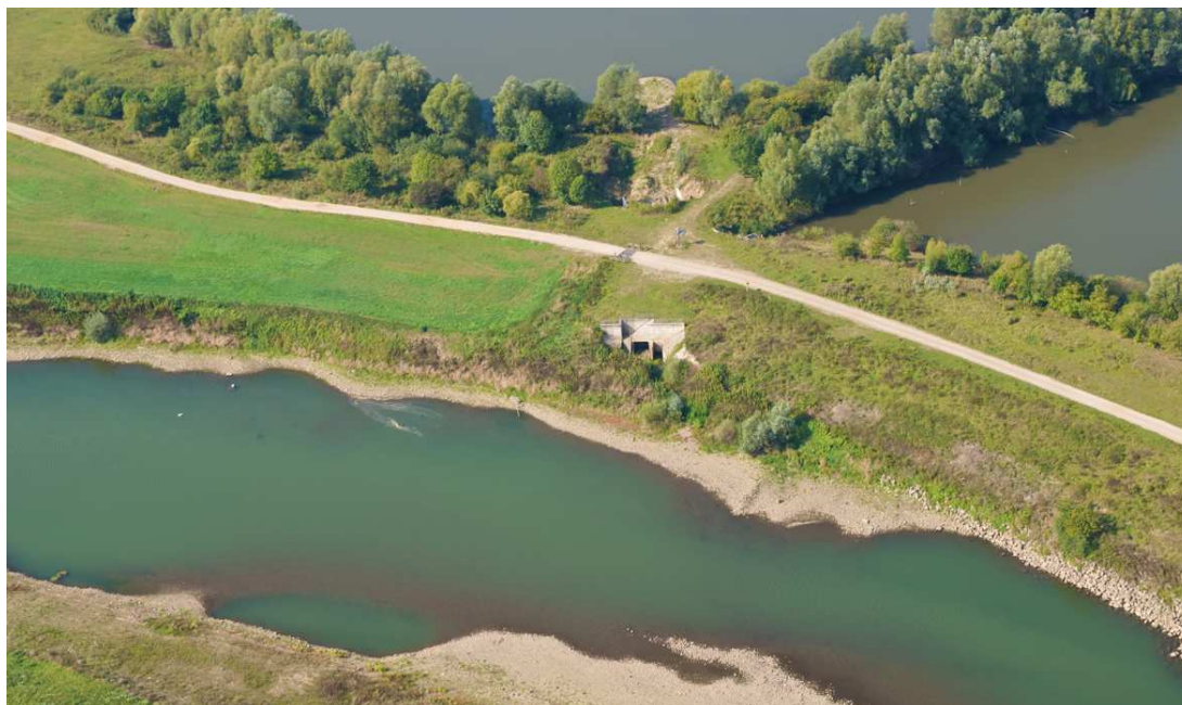
Illustratie 5.14: Voorbeeld van een inlaatconstructie, ingepast onder het maaiveld (Maesbeempder Greend (foto NV de Scheepvaart)
